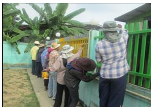
ภาพที่ 7 - 4 เปลี่ยนสีทาอาคารเป็นสีปลอดสารตะกั่ว
