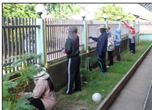
ภาพที่ 7 - 4 เปลี่ยนสีทาอาคารเป็นสีปลอดสารตะกั่ว
